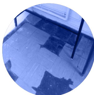
Dalles de sol
